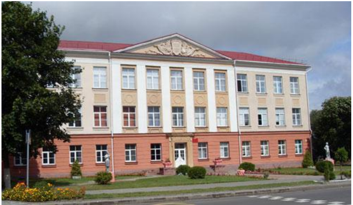
(Здание гимназии №1 г. Ошмяны)
